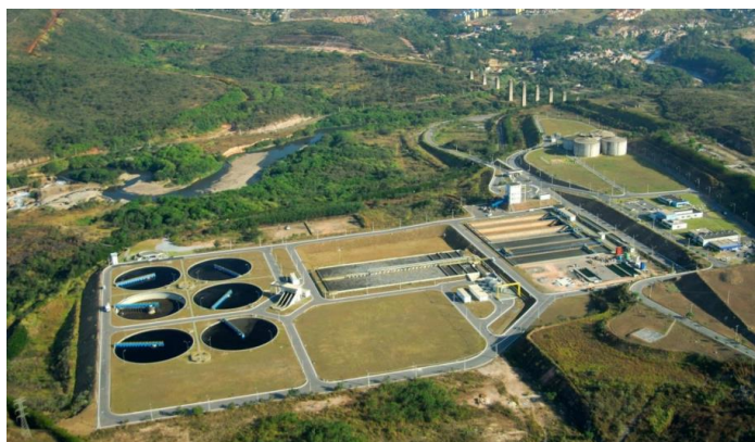
Figura 4 – Vista da ETE Arrudas
