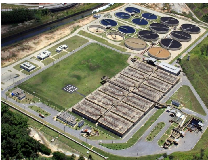
Figura5 – Vista da ETE Onça
